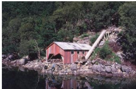
I Dyrskog var det eigen tømmerkog. Her er bilete av den nye saga etter som den gamle saga brann opp. Dette var ei oppgangssaga som blei driven av vasskraft.
